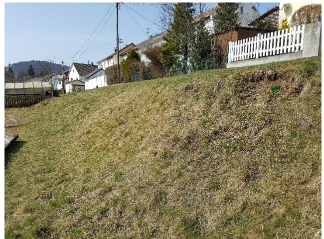
Foto 4: Grasböschung im Bereich des Spielplatzes entlang des Grasweges. Blickrichtung Südwesten.
