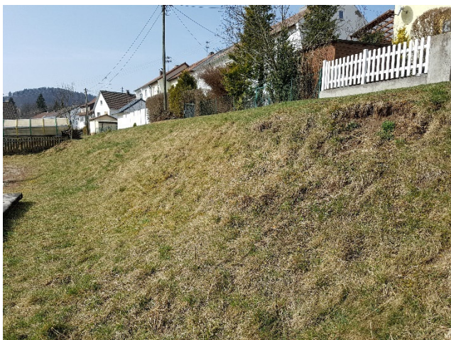
Foto 7: Grasböschung im Bereich des Spielplatzes entlang des Grasweges
