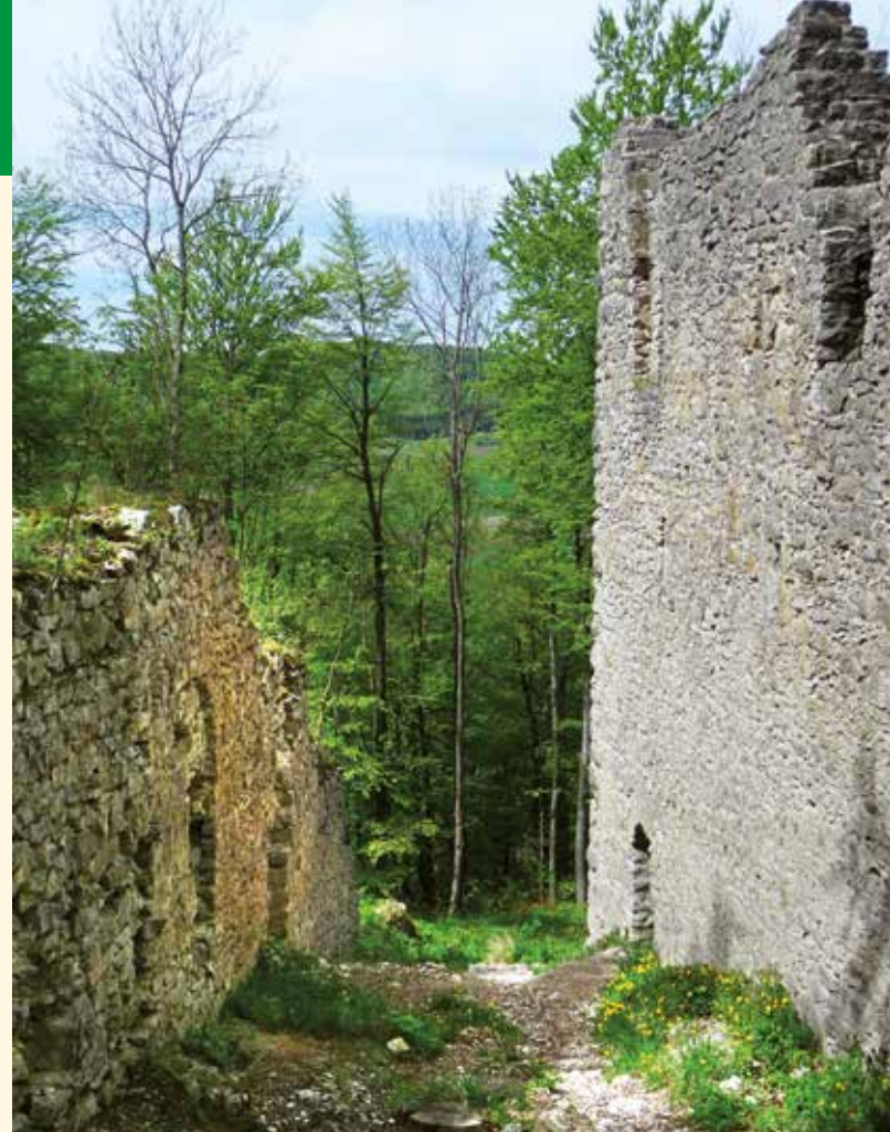
▲ Burgruine Melchingen, südliche Außenmauer (I) und Wohngebäude (r)
